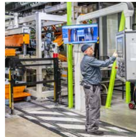
oben: Einrichten des Mittelbandes an der Laserschweißanlage für Coils [TWC].
